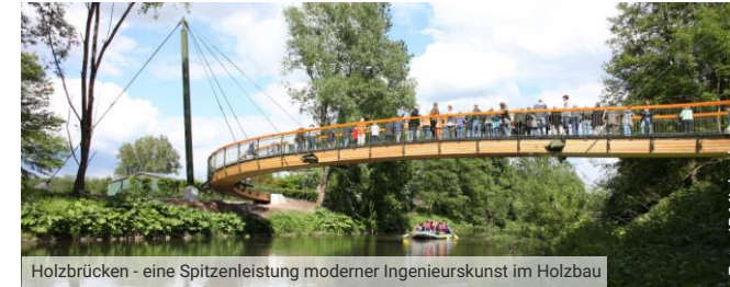
Holzbrücken - eine Spitzenleistung moderner Ingenieurskunst im Holzbau
