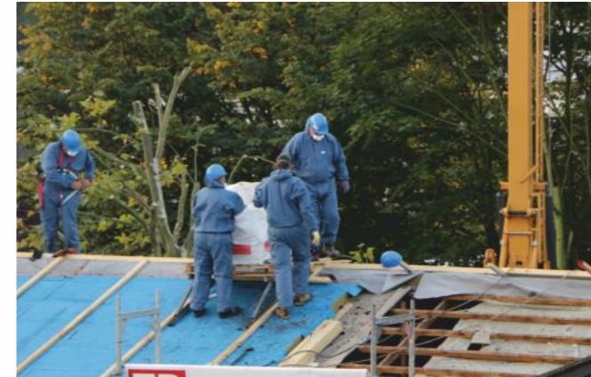
Asbest-Rückbau - eine verantwortungsvolle Aufgabe.
